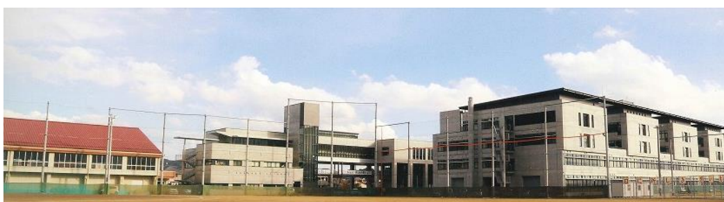
↑ 校舎全景 (左から体育館、管理棟、教室棟、実習棟)
